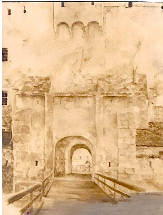
Eerste Westelijke toegangspoort. Met doorkijk op het binnenplein
