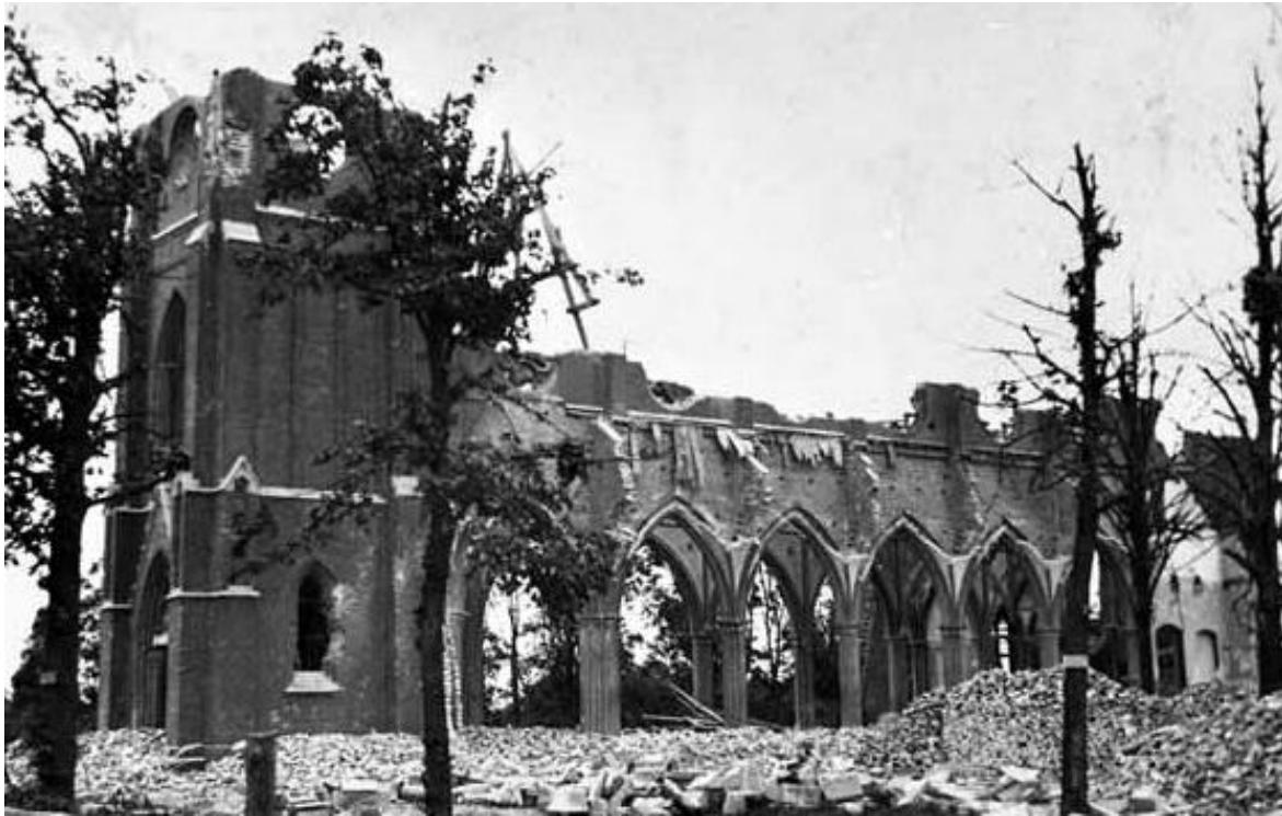
(Foto: kerk van Neerkant in puin)
