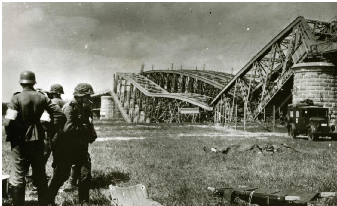
Opgeblazen IJsselbrug bij Westervoort 10 mei 1940
