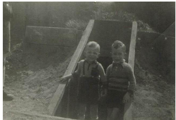
Henk en Rudy voor de ingang van de schuilkelder
